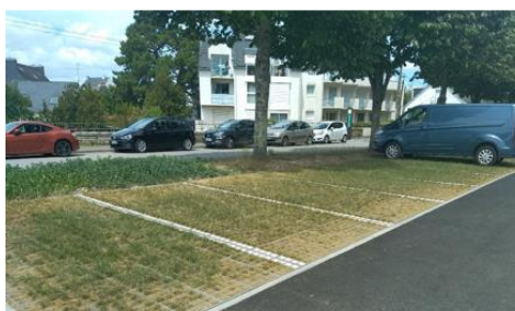
Fonction de stationnement + fonction hydraulique = parkings perméables
