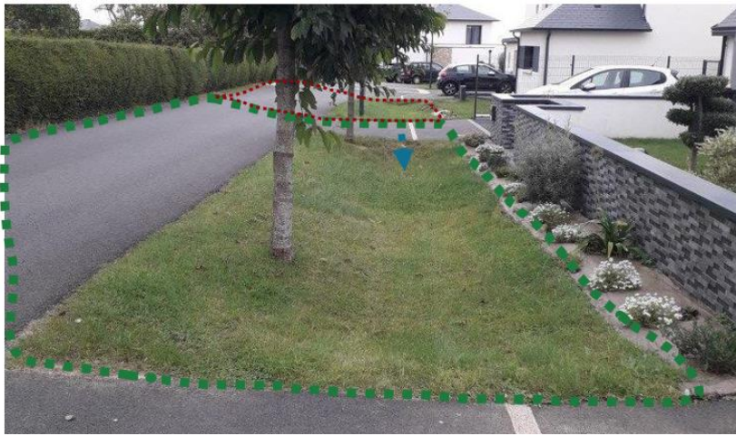
Gestion de la surverse en superficiel
