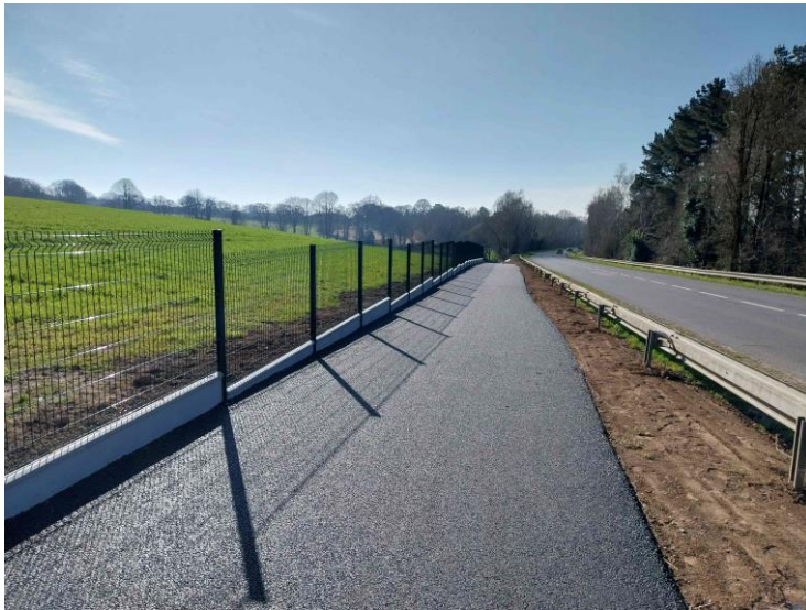
Voie verte le long de la RD779 et d'une parcelle agricole
