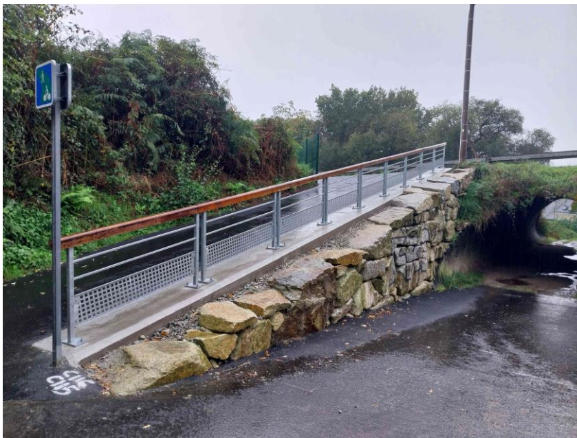
Garde-corps de la voie verte à Pratel Mat
