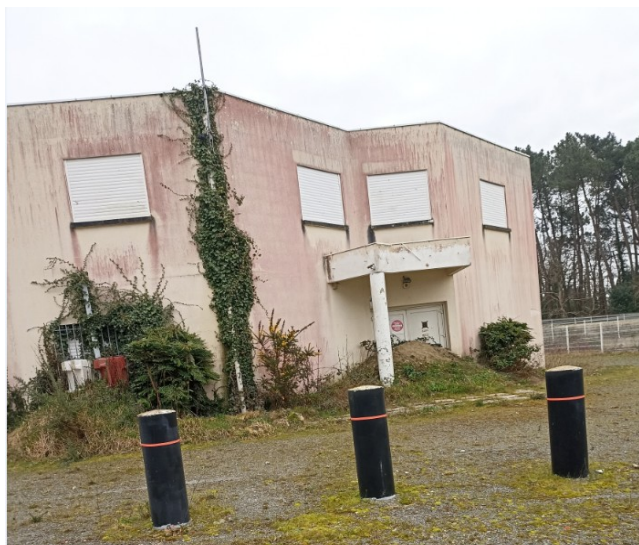
Partie avant du bâtiment donnant sur la voie interne de la zone d'activité
