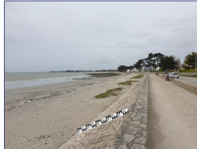
Mesure sur échelle ou autre marqueur sur l'ouvrage
