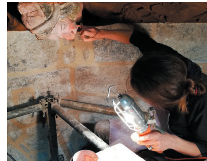
Restauration d'une des sablières du chœur de l'église Saint-Alban, Atelier Régional de Restauration © Commune d'Elven
