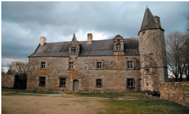
Ancienne ferme, village de Bizole, Tréfléan © GMVa
