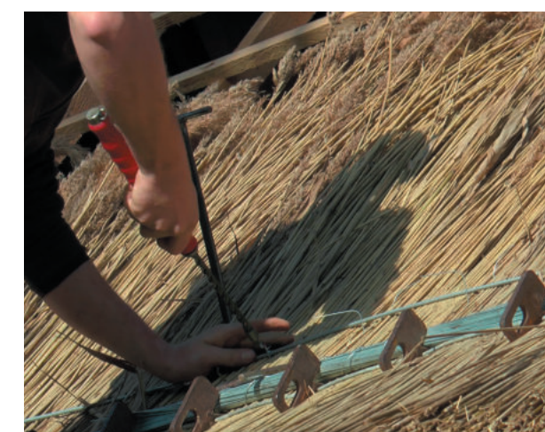
Fixation des fils de ligature, savoir-faire chaumier © PNRGM
