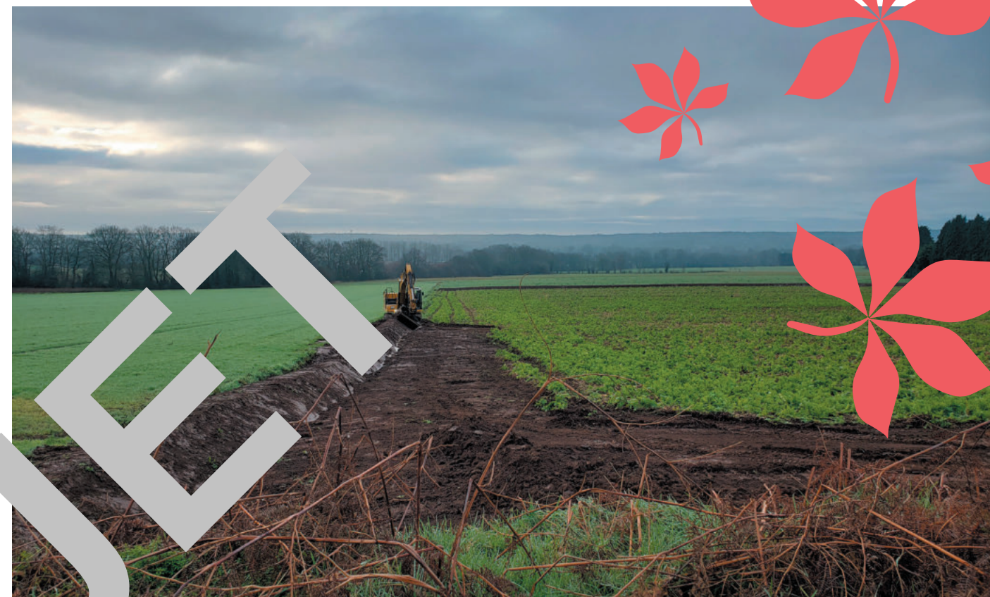
Travaux de restauration des talus et plantation, février 2023, Plaudren.
