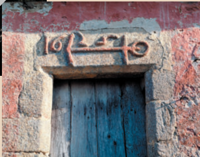
Détail architectural, date portée 1625 et ancre marine sculptée dans le linteau © Service de l'Inventaire
