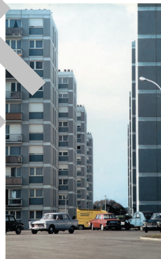
Quartier de Kercado vers 1970 © Archives municipales de Vannes
