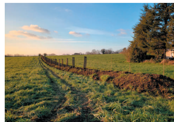
Travaux de plantation, décembre 2022, Tréfléan. © GMVa
