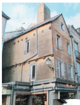
Exemple d'un projet de restructuration complète d'un immeuble à pan de bois accompagné par Golfe du Morbihan - Vannes agglomération.
