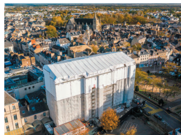
Chapelle Saint-Yves, vue aérienne du chantier © Julien Gazeau
