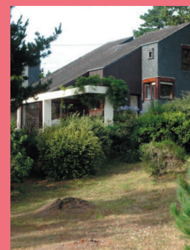
Maison Arié, l'Île-aux-Moines, 1987, Architecte Bernard Guillouët
