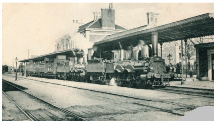
Arrivée du train en gare de Vannes, fin du XIX e siècle © Archives départementales du Morbihan
