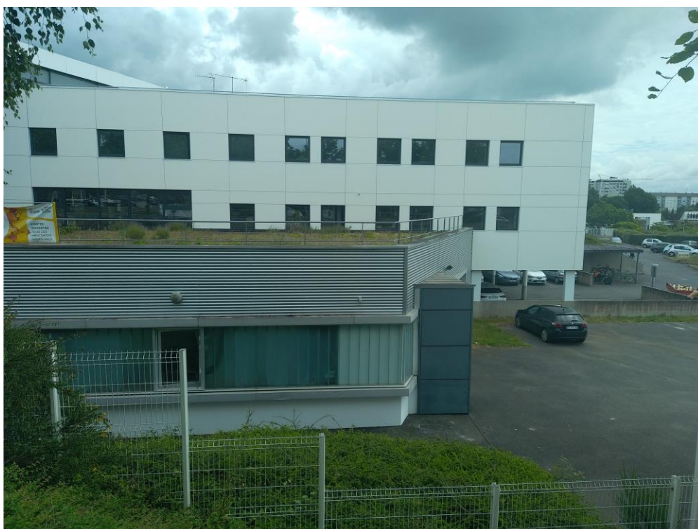
Figure 4 : Toiture végétalisée, ICAM, Vannes
